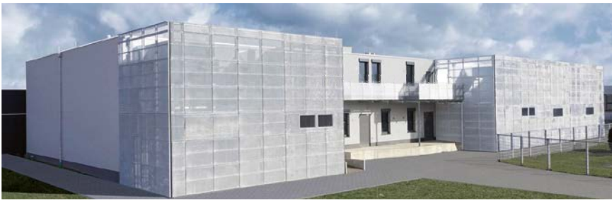
Das Rechenzentrum LEV-1 wurde in sechs Monaten gebaut
